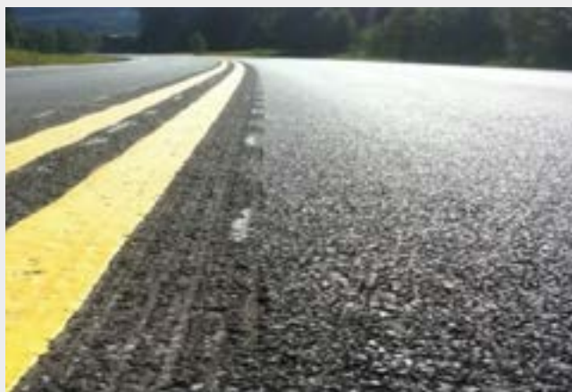
Beispiel eines durchgehenden Striches in einer flach ausgefrästen Spur
