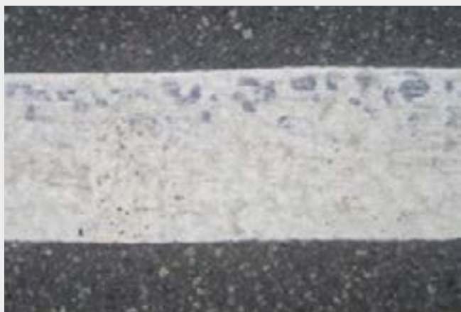
Beispiel eines beschädigten durchgehenden Striches
