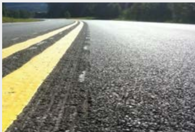
Exemple d'une ligne continue dans une plate-bande de fraisage
