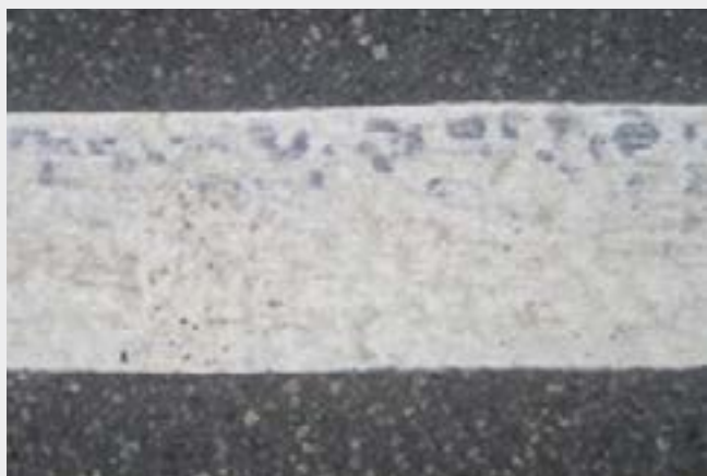
Exemple d'une ligne continue endommagée
