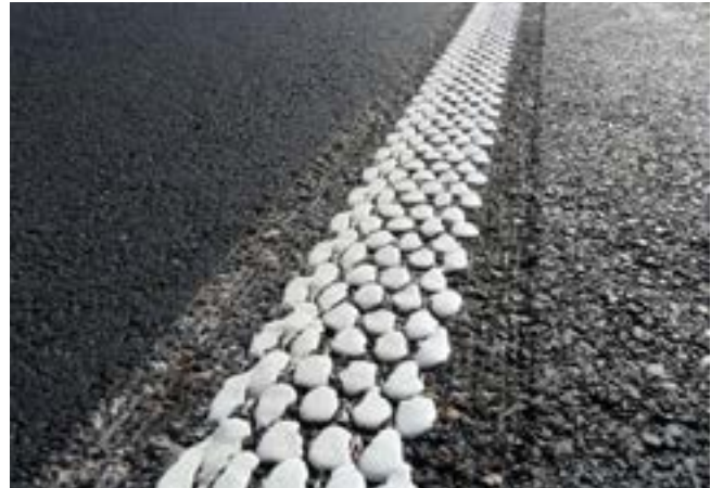
Exemple d'une ligne pointillée dans une bande de fraisage
